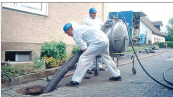
Der Bagger bleibt außen vor: Schlauchlining einer Grundleitung. Solche Dienstleistungen kaufen Grundstückseigentümer am besten gemeinsam ein.
